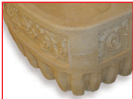
Esempio di incisione laterale e svuotatura di un massello.
